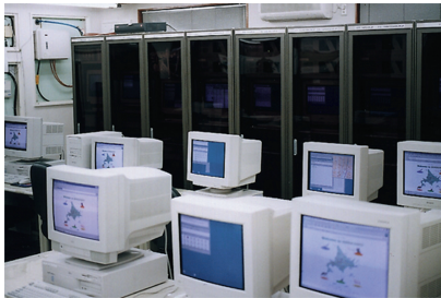
当時のネットワーク設備
